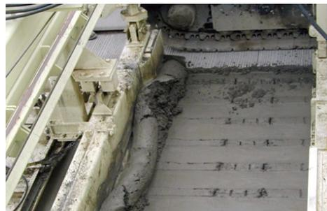
Выглаживающая маятниковая плита, как часть системы дюбелезакладки, тщательно выглаживает поверхность, нарушенную после закладки дюбелей.
