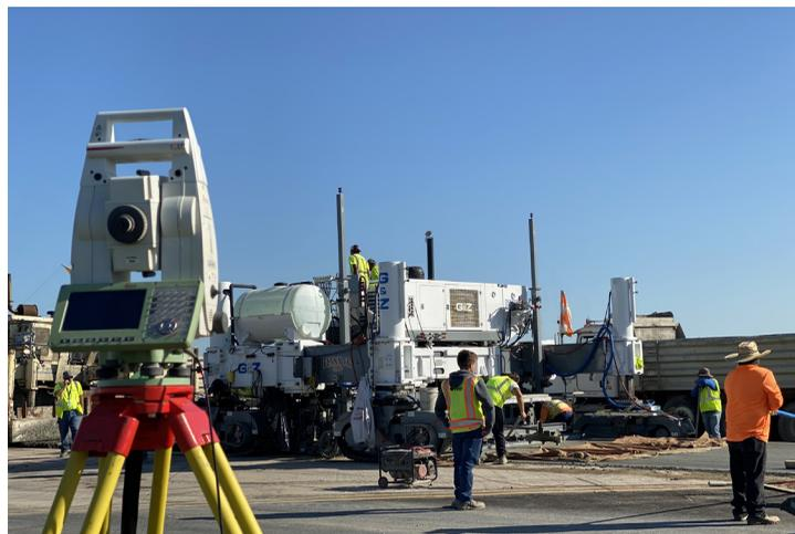
NoLine состоит из обновления EGON и крепёжного комплекта. Обновление EGON NoLine включает использование бесструнной технологии от третьей стороны прямо в CAN-шину сети машины.
